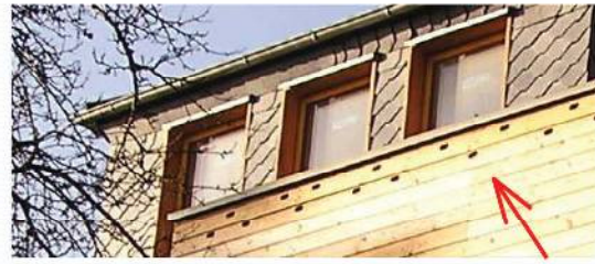
Integrative Artenschutzmaßnahme für Mauersegler und Haussperling, Karl-Roth-Straße
