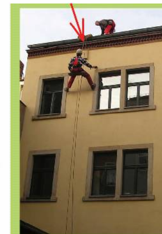
Freiwillige Artenschutzmaßnahme am Projekttheater Dresden mit Hilfe der Firma Steimann Alpinetechnik, Anbringen von Mauersegler- bzw. Haussperlingskästen und Fledermauskästen
