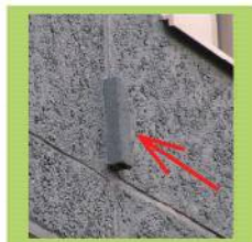
Fledermausröhre am WBS 70, Bulgakowstraße
