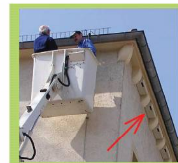
Nachträgliche Anbringung von Mauersegler- und Haussperlingssteinen an einer Schule, Görlitzer Straße
