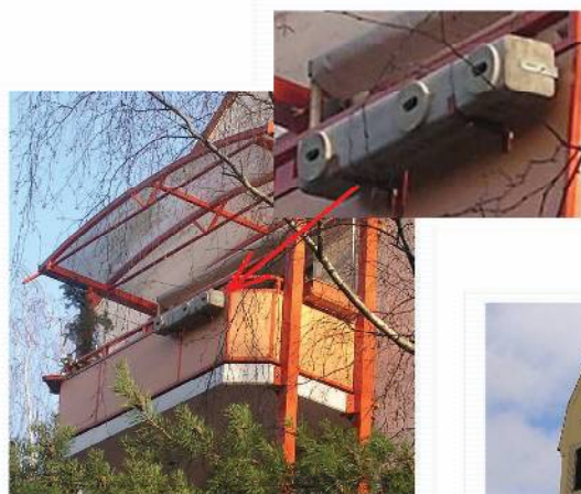
Mauersegler- und Haussperlingskasten (3-fach) am Balkon einer Privatwohnung, Rugestraße
