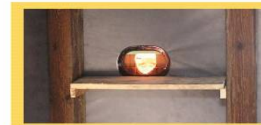
Ein Fledermauslüfterziegel ermöglicht Fledermäusen den Einflug in den Dachstuhl, Tetschener Straße
